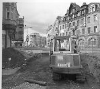
Straßenbau am Dresdner Schillerplatz
