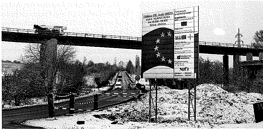
Die EU fördert den Ausbau der grenzüberschreitenden Infrastruktur. Im Bild: Bau der D8 von Dresden nach Prag.
